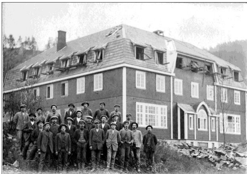
Skulehuset på Utsund under bygging i 1913
