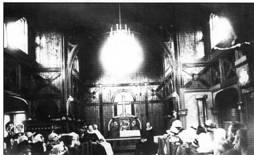
Vigslingi av Fjågesund kapell, 1916. Biskop Støylen. Presten Bergeland.
