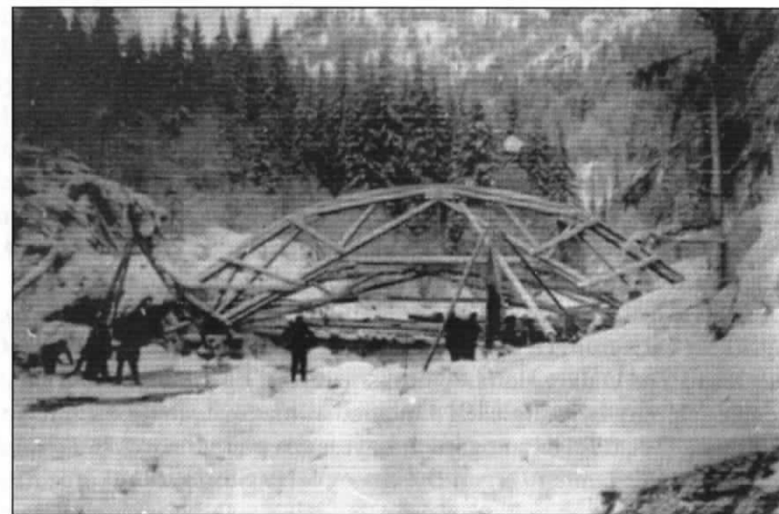
Arbeid på Bjørnflaten bru over Dala-Ål
