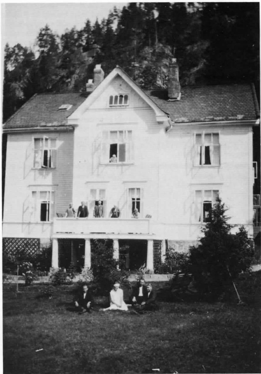
Granlien som det var i 1914.
